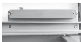
Das Stahlblech an die vorgelochte linke Führungsschiene montieren.
